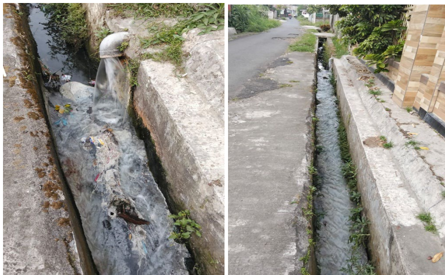
Gambar 4. 2 Saluran Pembuangan Limbah Langsung Ke Drainase
