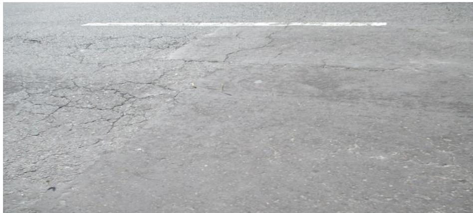
Gambar 2.1 Retak Halus (*Hair Cracking*)
