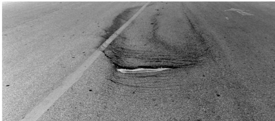
Gambar 2.4 Retak Selip (*Slippage Crack*)
