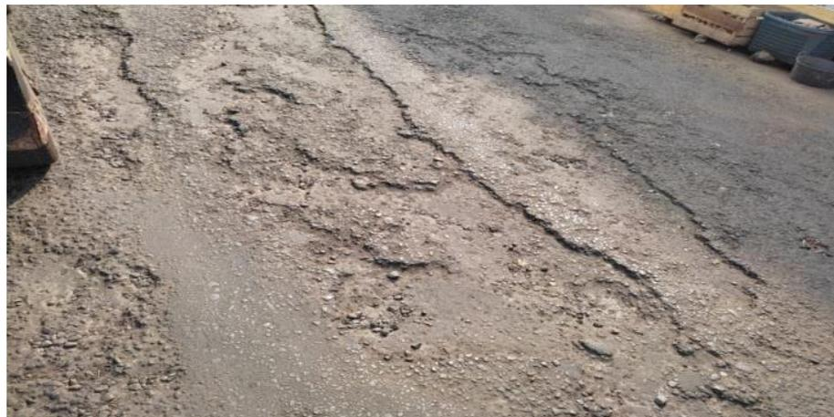
Gambar 2.9 Pengelupasan Lapis Permukaan (*stripping*)
