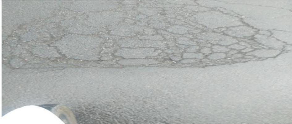
Gambar 2.2 Retak Kulit Buaya (*Alligator Crack*)
