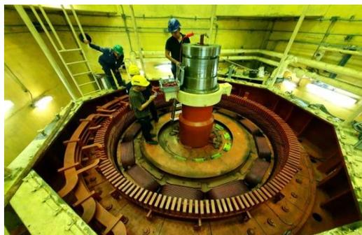
Gambar 2. 1 Konstruksi Stator PLTA Musi
