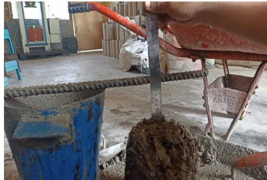
Gambar 3.10 Pengujian slump test
