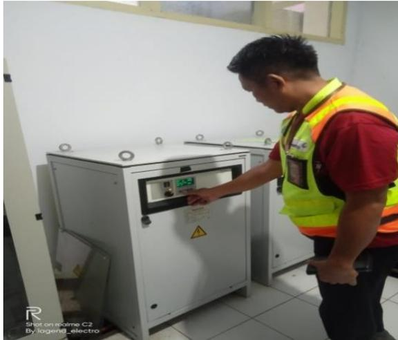
**Gambar 4.4 Pengoperasian PAPI secara local**
