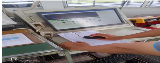
**Gambar 4.5 Pengoperasian PAPI secara remote**
