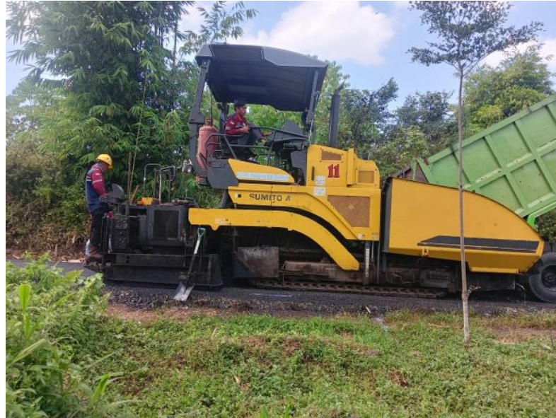
Gambar 4.17 Pekerjaan Penghamparan Hotmix AC-BC
