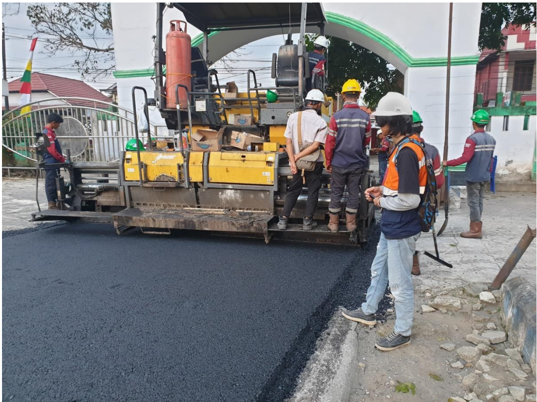
Gambar Pekerjaan Pengawasan Pengaspalan AC-BC
