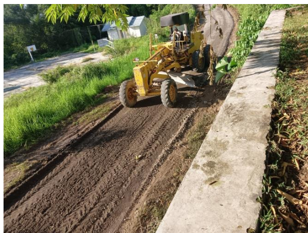
Gambar 4.14 Pekerjaan Pondasi Agregat Kelas A
