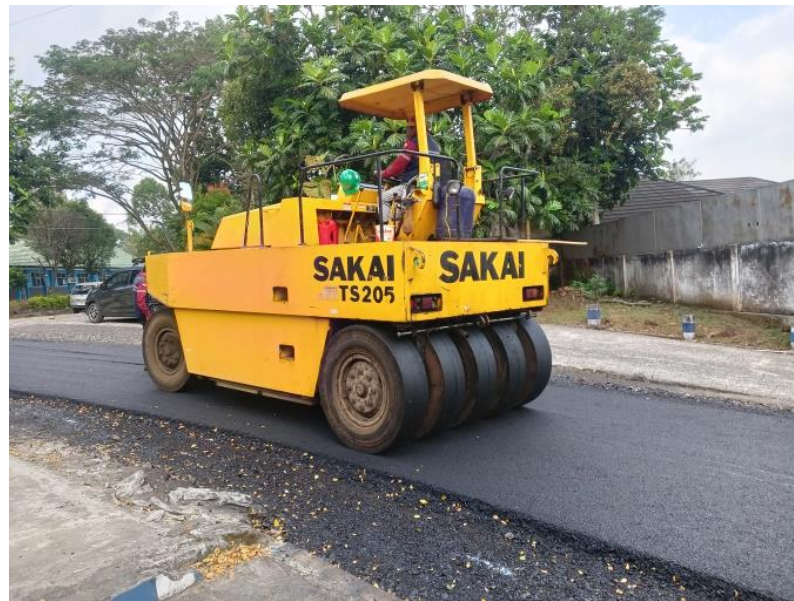
Gambar 4.19 Pekerjaan Pemadatan Dengan Menggunakan Pneumatic Tire Roller
