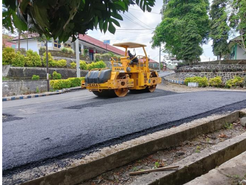
Gambar 4.18 Pekerjaan Pemadatan Menggunakan Tandem Roller
