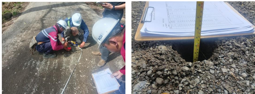
Gambar 4.15 Pekerjaan Core Drill
