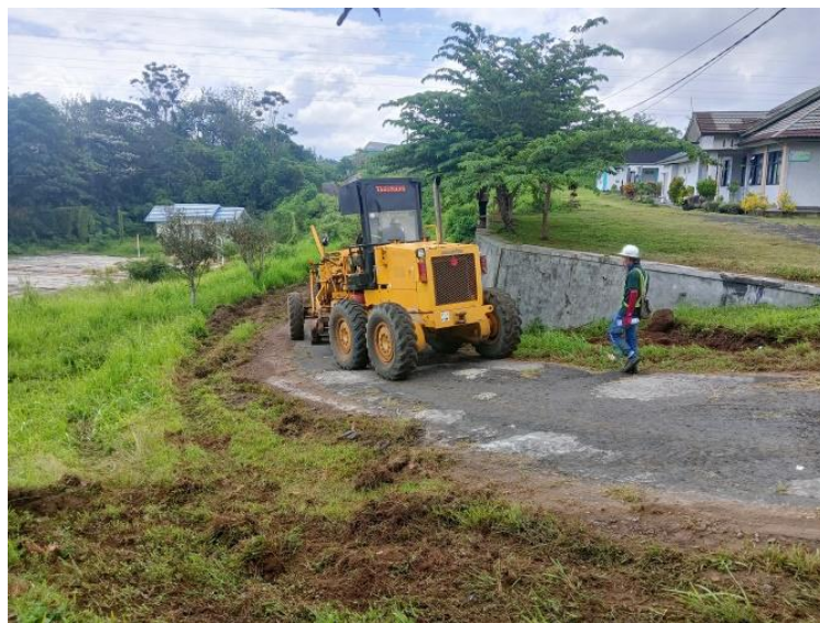
Gambar 4.13 Pekerjaan pembersihan lahan
