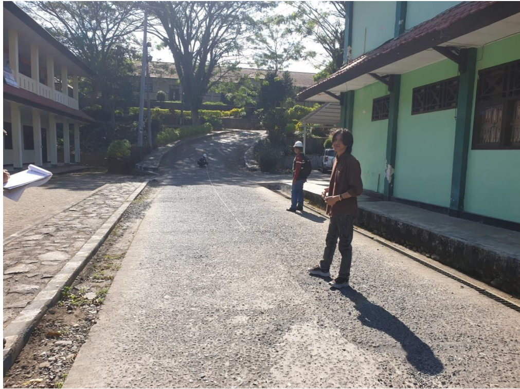
Gambar Pekerjaan Pengukuran
