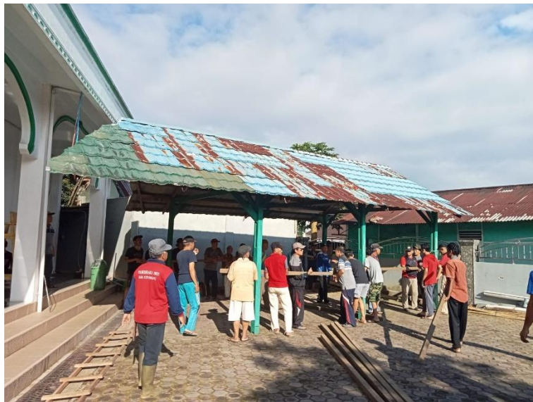
Gambar 4.2 pembersihan rencana lokasi pembangunan
