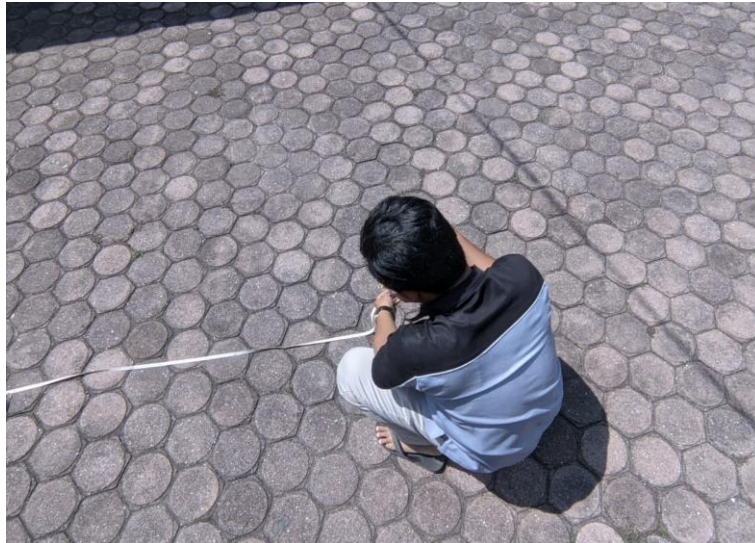
Gambar 4.4 pengukuran rencana lokasi gedung
