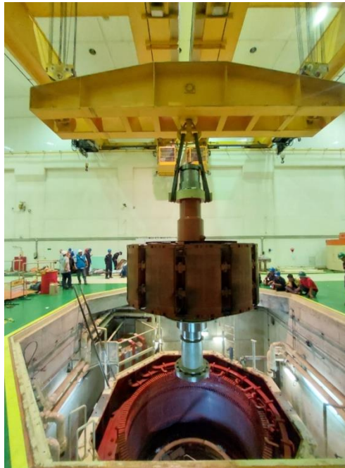
Gambar 4.4 Proses overhaul di PLTA Musi
