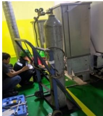
Gambar 2.19 Pengisian Gas SF6 pada GCB
