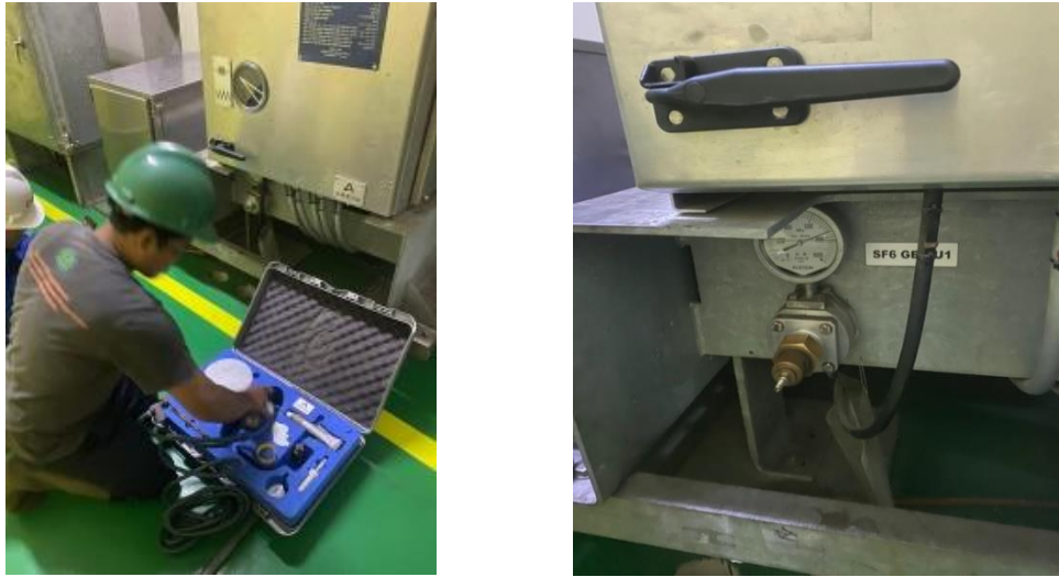
Gambar 4.3 Pemeriksaan tekanan gas SF6
