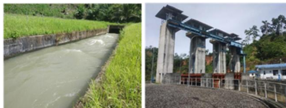
Gambar 2.6 Tailrace (kiri) dan regulating dam (kanan) PLTA Musi
