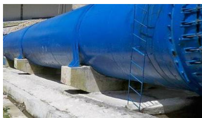
Gambar 2.4 Penstock pada PLTA secara umum
